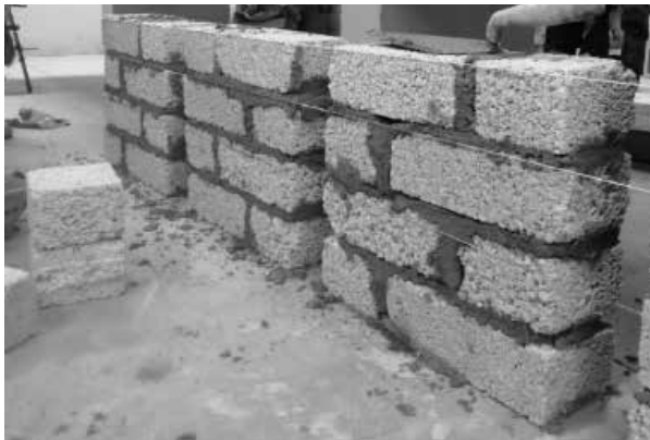
Figura 2. Construcción de muretes.
