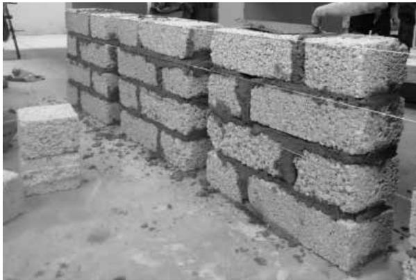
**Figura 2.** Construcción de muretes.
