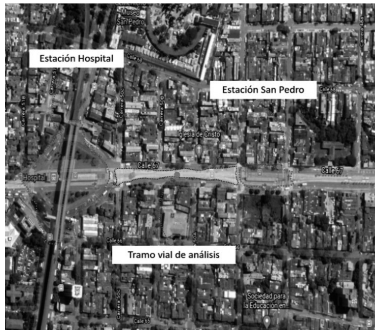
Figura 1. Tramo vial entre las estaciones Hospital y San Pedro. Fuente: Elaboración propia a partir de imagen proporcionada por Google maps (2020).
