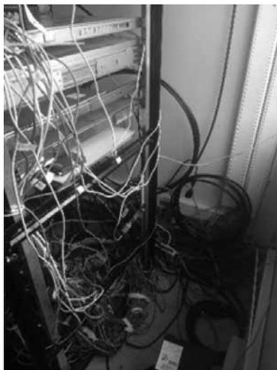
Figura 7. Estado de cableado estructurado en el hospital regional de El Líbano. Fuente: Elaboración propia.
