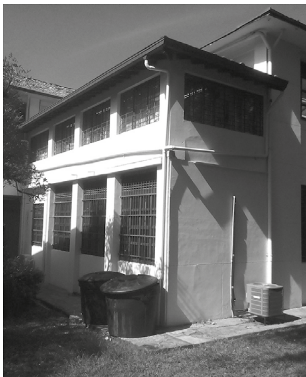
Figura 1. Sistema de captación de agua lluvia en la I.U Colegio Mayor de Antioquia
